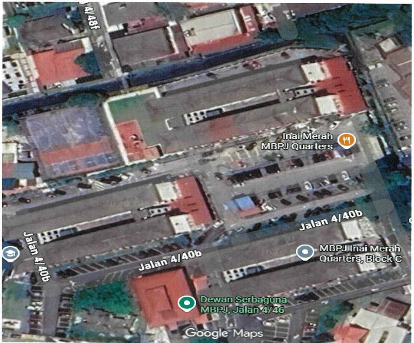
KUARTERS INAI MERAH BLOK A, B, C, SURAU DAN DEWAN SERBAGUNA, JALAN 4/46, PETALING JAYA
